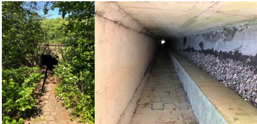
PHOTO 20 : PASSAGE SOUS LA E411 VENELLE AUX CAILLOUX/CHEMIN DES CHARRONS - (SOURCE : AGORA, 2019)
