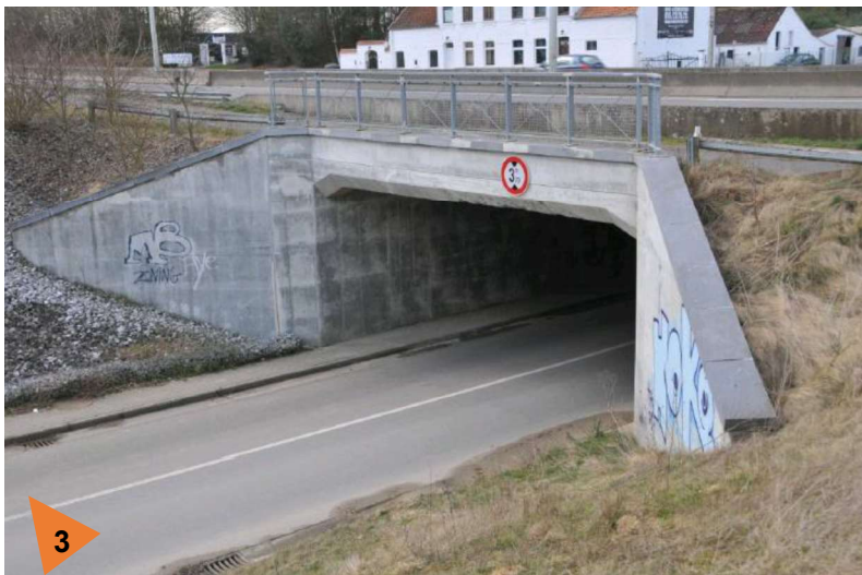
PHOTO 17 : PASSAGE SOUS-VOIE DU CHEMIN DE VIEUSART – PÉRIMÈTRE DU SOL IMPLANTÉ DE L'AUTRE CÔTÉ DE LA RN25 – (SOURCE : AGORA, 2018)
