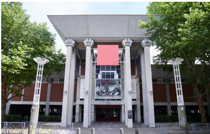
Figure 11. Le centre commercial Belle-Ile à Liège est localisé au bord de l'Ourthe, sur une ancienne friche industrielle. Il a été construit sur pilotis de manière à minimiser les mouvements de terre et à réduire la vulnérabilité des fonctions commerciales, localisées au-dessus du stationnement.
