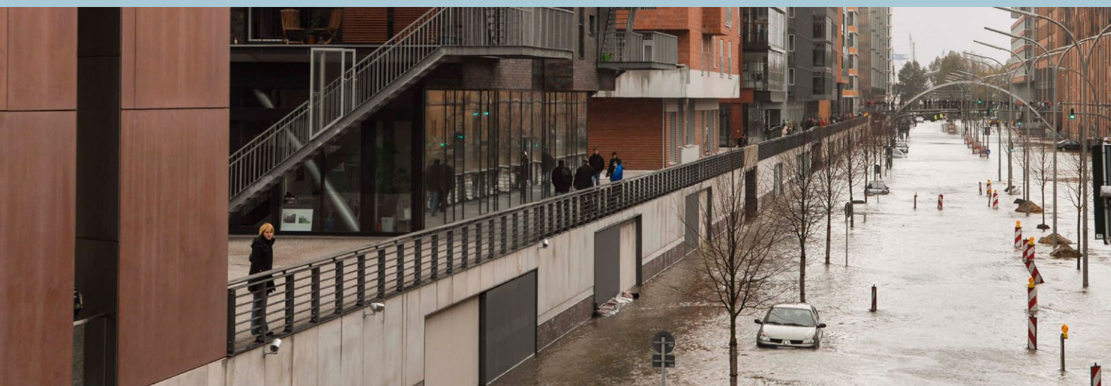
Inondation à HafenCity Hamburg. Crédit photo: ELBE&FLUT: Thomas Hampel
