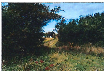
PHOTO 22 : PARTIE NON REVÊTUE DE LA VENELLE AUX CAILLOUX – (SOURCE : AGORA, 2019)
