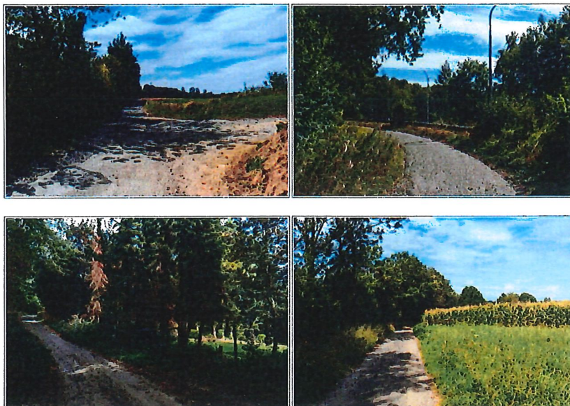
PHOTO 18 : VUES DU CHEMIN DES CHARRONS – SECTION SUPÉRIEURE - (SOURCE : AGORA, 2019)
